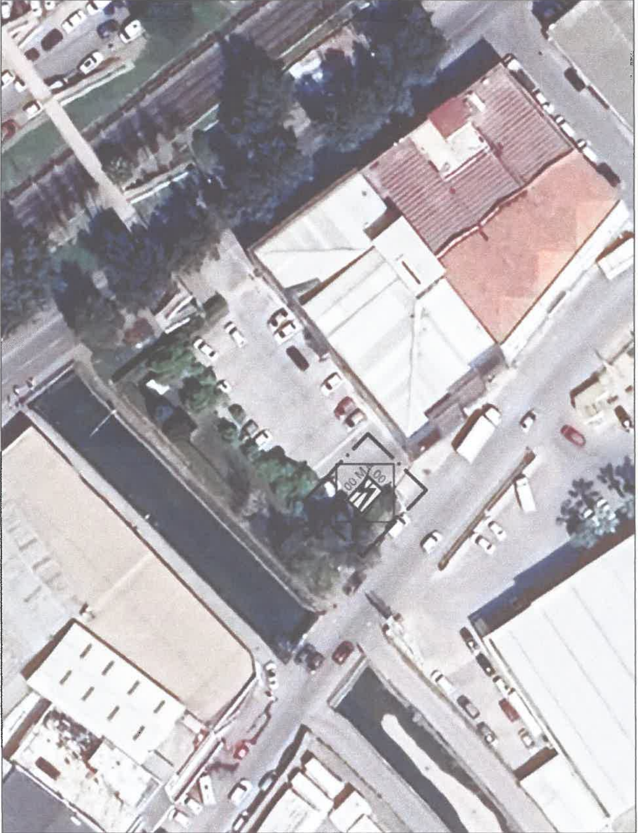
-Trafo Alanının Uydu Görüntüsündeki Konumu-
